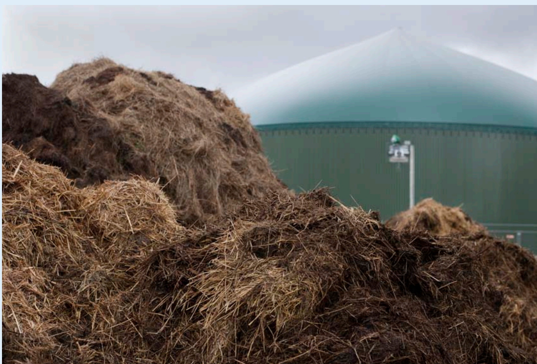
Биогазовая установка в Трехвитце работает на твердом и жидком навозе.
