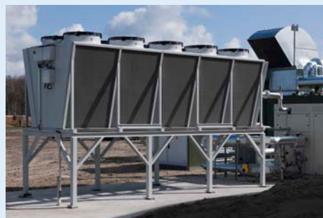
Разработанный специально для энергетического сектора, конденсатор GVD охлаждает рабочее вещество, используемое в процессе ORC.
