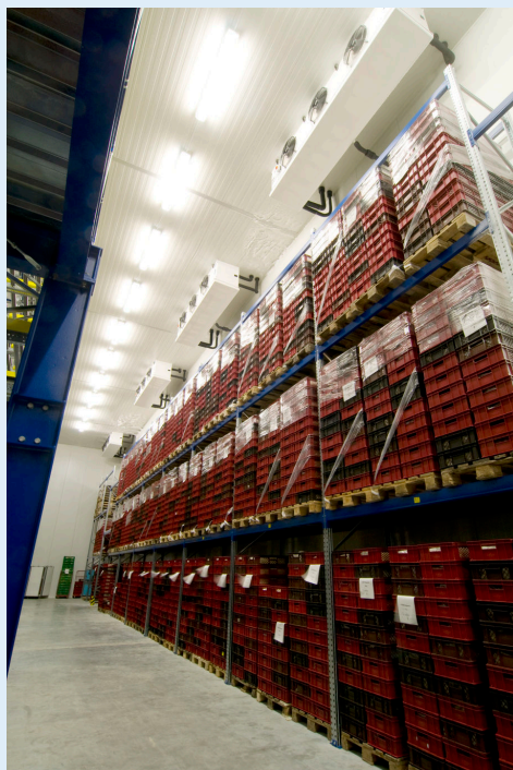
Испаритель CO 2 в морозильной камере
