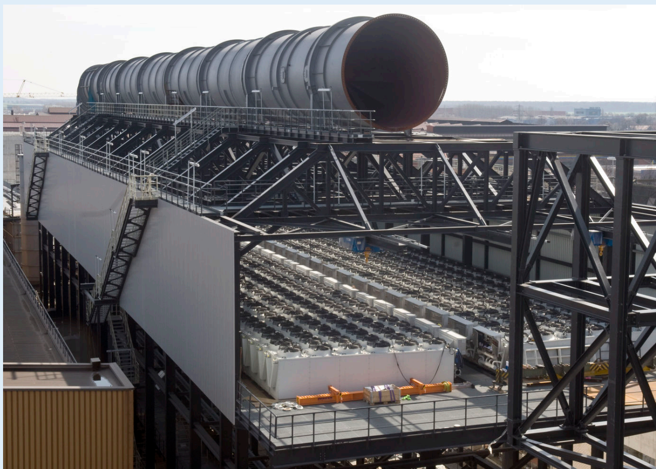
Для этой установки компания Güntner поставила 64 сухих охладителя
